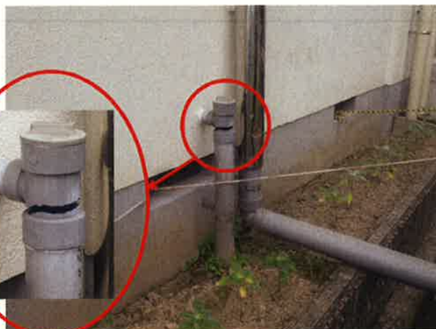
給水管破損
